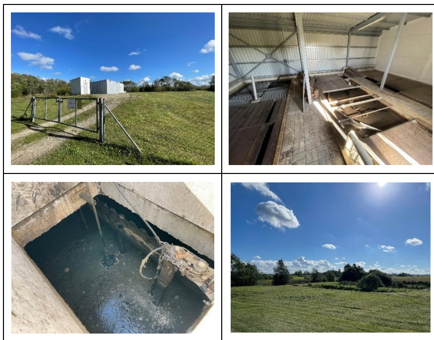
Fotod 5.8 Puurmani reoveepuhasti ja biotiigid (2023).
