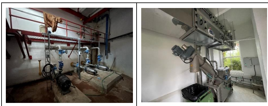
Fotod 5.2 Põltsamaa RVP peapumpla (RP-1) ja purgla automaatvõre (2023).
