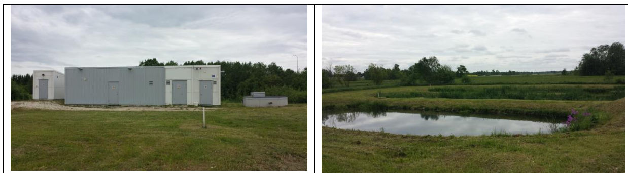
Joonis 6. Puurmani aleviku reoveepuhasti.
