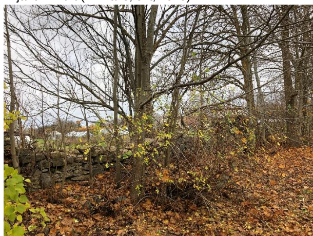
Foto 9 Vaade mõisa aia piirdemüürile planeeringuala lääneküljel (M. Kalle, okt, 2019)
