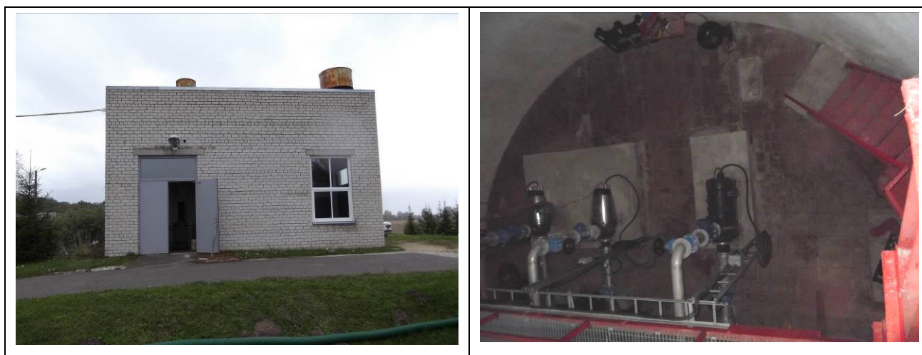
Joonis 10. Põltsamaa linna reovee peapumpla. Foto: OÜ Alkranel 30.09.2013.
