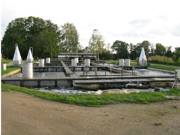
Joonis 7. Vaade Härjanurme kalakasvanduse forellibasseinidele (vasakul) ning basseinide sissevoolule, kus vesi on õhustamiseks juhitud üle paiskärrestiku (paremal).
