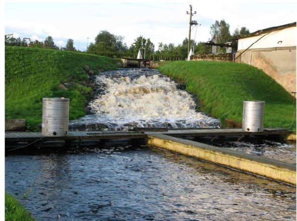
Joonis 7. Vaade Härjanurme kalakasvanduse forellibasseinidele (vasakul) ning basseinide sissevoolule, kus vesi on õhustamiseks juhitud üle paiskärrestiku (paremal).
